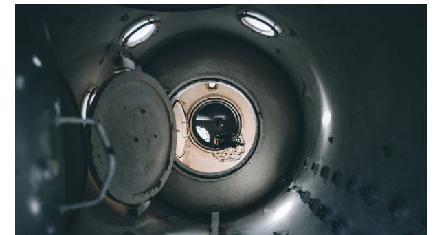
Tarkastuskohteita ovat esimerkiksi kattilat, säiliöt, siilot, savupiiput tai rakenteet.
